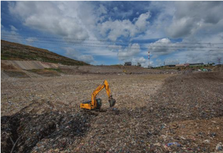
Evsel atıklar, belediyeler tarafından İZAYDAŞ'a getirildikten sonra, atıklar özel hazırlanmış zemine seriliyor ve üstü kapanıp bertaraf ediliyor.
