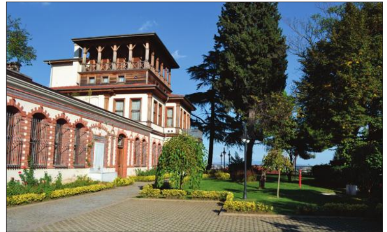
Kapanca Sokağı'nda görkemli yapısıyla dikkat çeken Sırrı Paşa Konağı.
